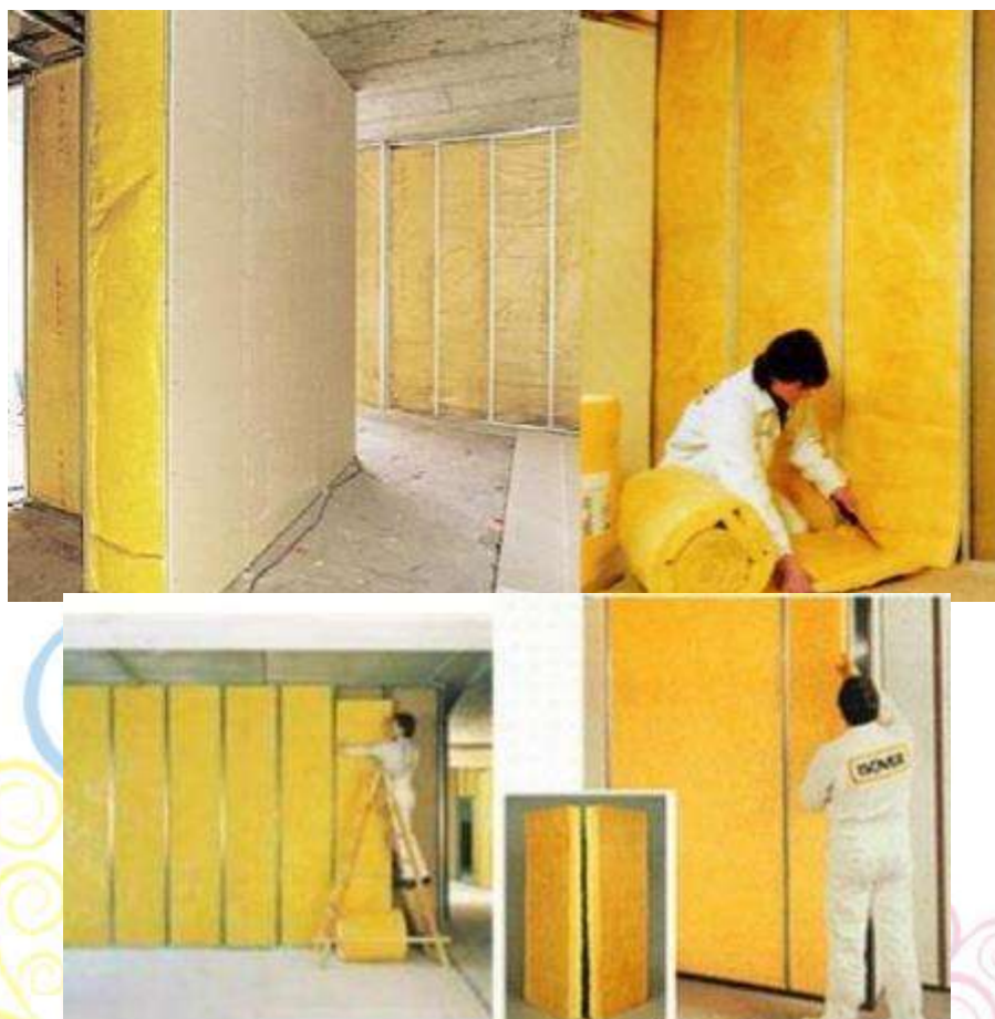
Ejemplos de colocación de paneles de fibra de vidrio de forma uniforme entre canales de los perfiles de sujeción de sistemas prefabricados de yeso-cartón.
